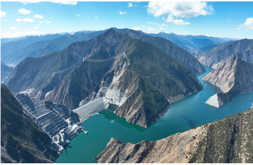
两河口水电站 水电五局 提供
